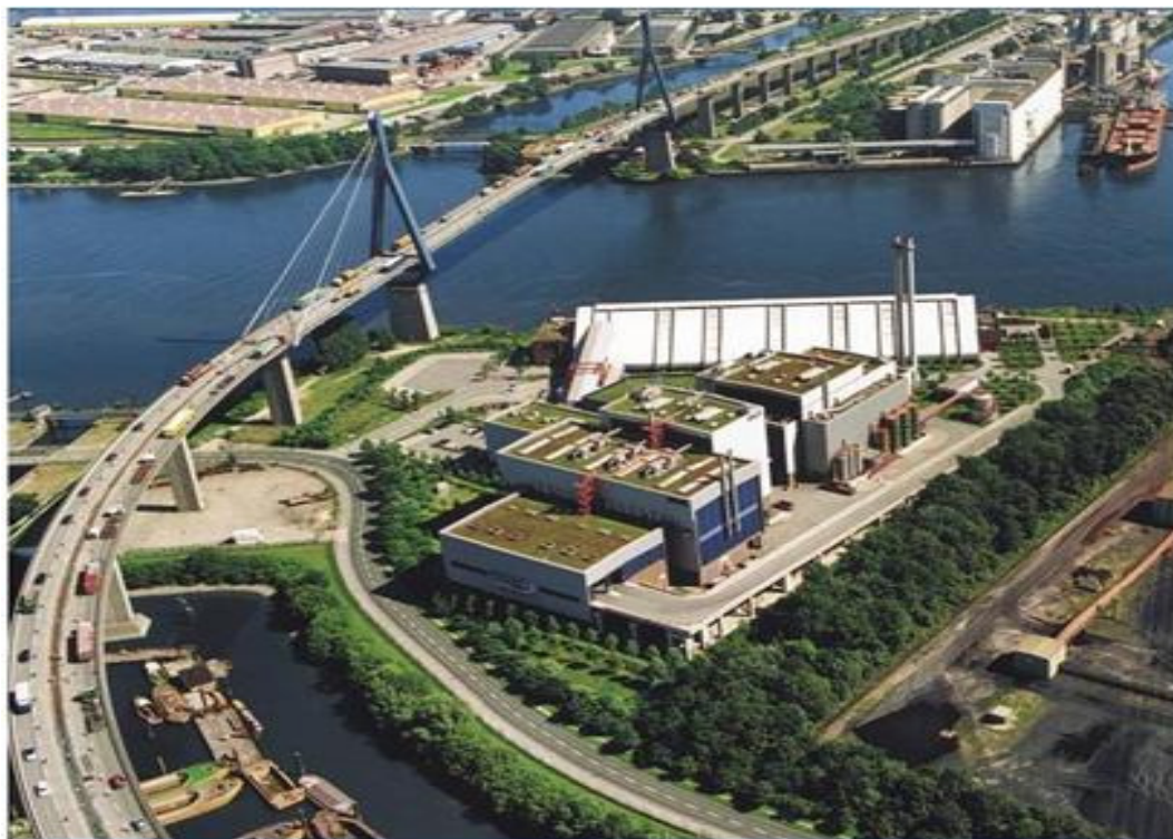
*Mullverwertung Rugenberger Damm (MVR) Facility in Hamburg, Germany
